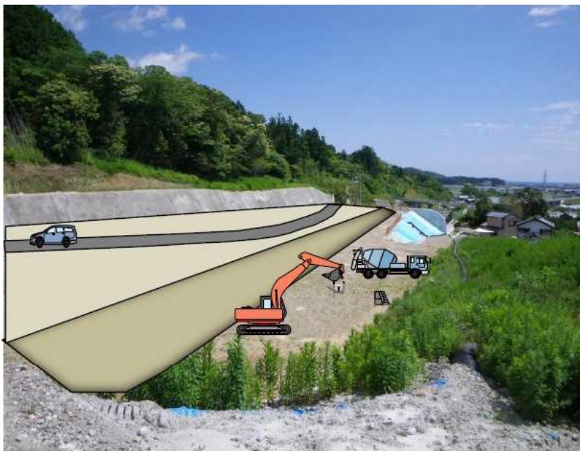
西側のブロック積み擁壁をつくります。
