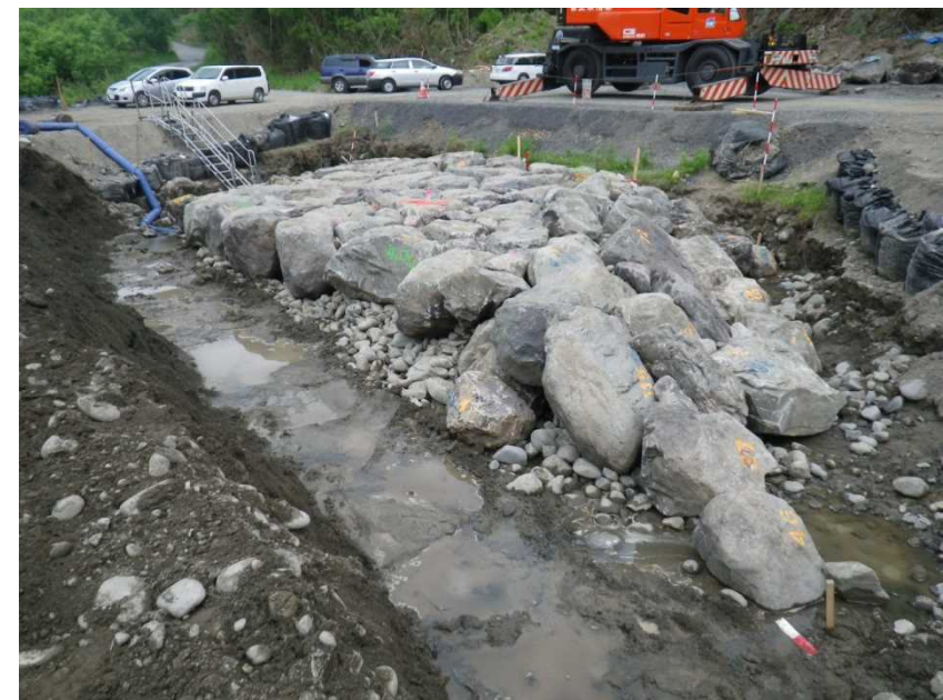
巨石設置完了
