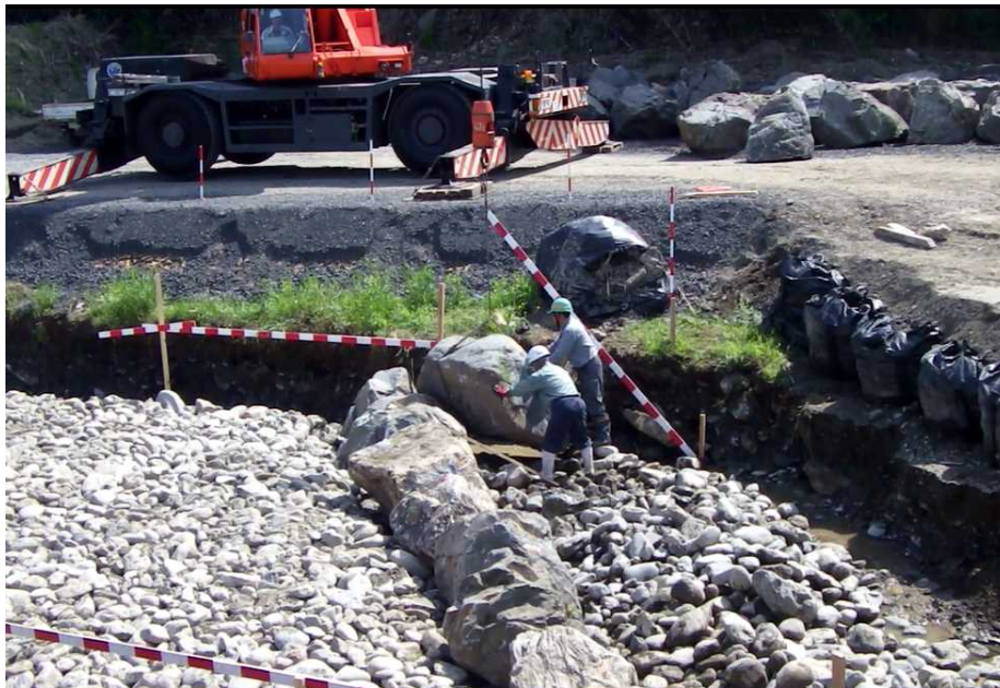
巨石組み実施中
