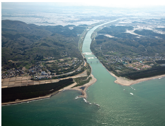
河口からみた分水路（13年5月撮影） 工事費の内訳は第二床固改築（大河津分水路）が373億6,700万円、堤防整備（58*）が270億9,800万円、河道掘削（1,572万5,000立方*）が656億8,800万円、護岸（10*）が84億7,500万円、樋門（1基）が5億5,000万円、付帯工事が115億3,500万円となる。
