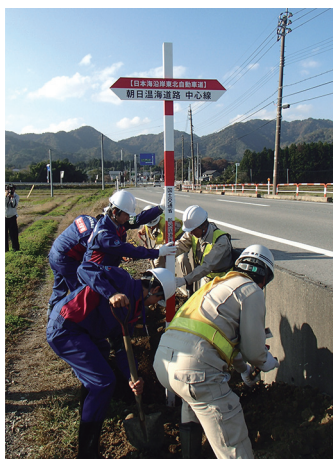
13年11月6日に中心杭を設置
