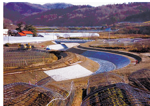
護岸改修工事（完成後）
