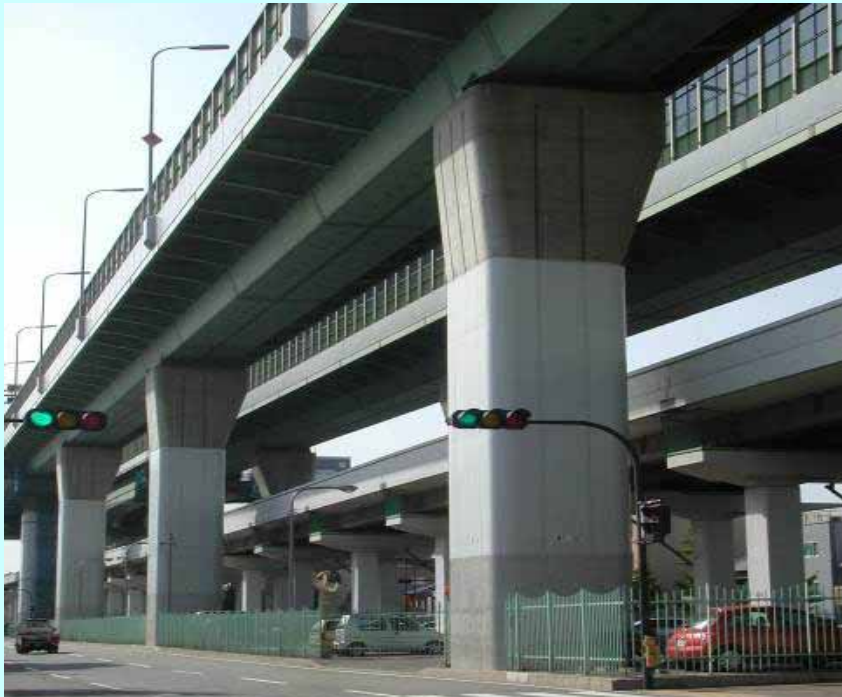
阪神高速道路の橋脚
