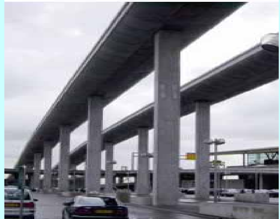
シャルル・ド・ゴール空港の アクセス道路の橋脚
